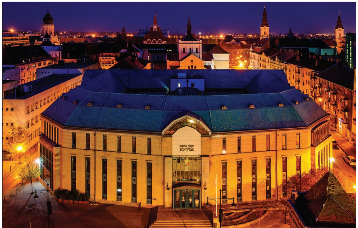
44. ábra. A Katona József Megyei Könyvtár épülete, 2018 Fig. 44 The building of the Katona József County Library, 2018 Fotó/Photo: Borsos Szilárd
