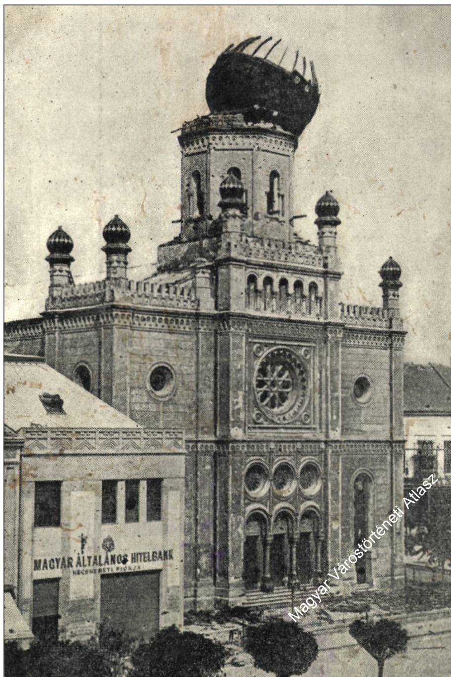
30. ábra. Az új zsinagóga földrengésben megrongálódott kupolája, 1911 Zempléni Múzeum Képlaptára, Ltsz.: 0221774 Fig. 30 The dome of the new synagogue damaged in an earthquake, 1911 Zemplén Museum, Collection of Postcards, Inv. No.: 0221774
